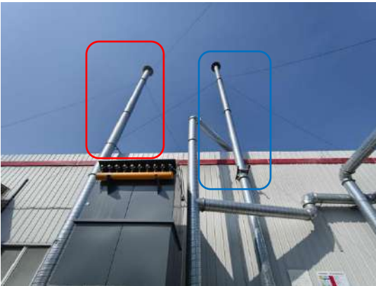
3#排气筒和 2#排气筒
