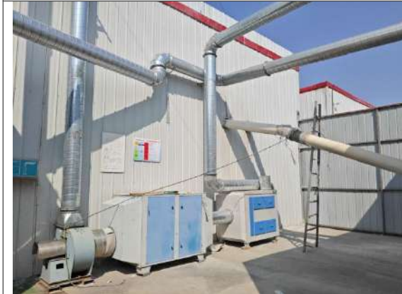
原料库废气处理装置“初、中效过滤+二级活性炭吸附”
