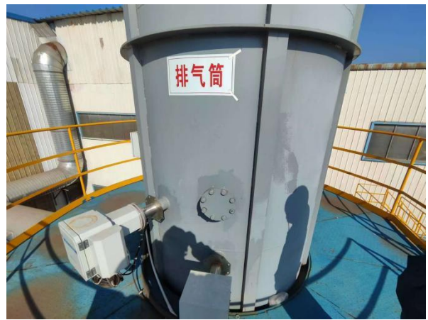
排气筒采样口照片
