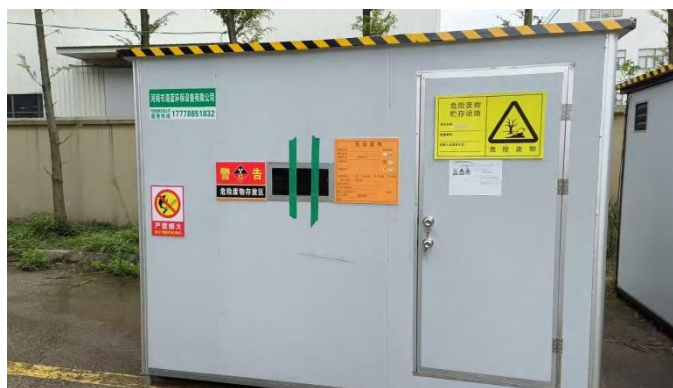
图 3-4 危险废物暂存库照片
